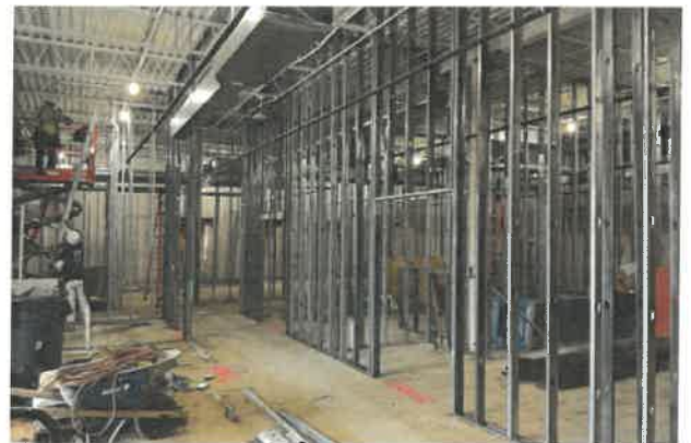
Metal stud framing
